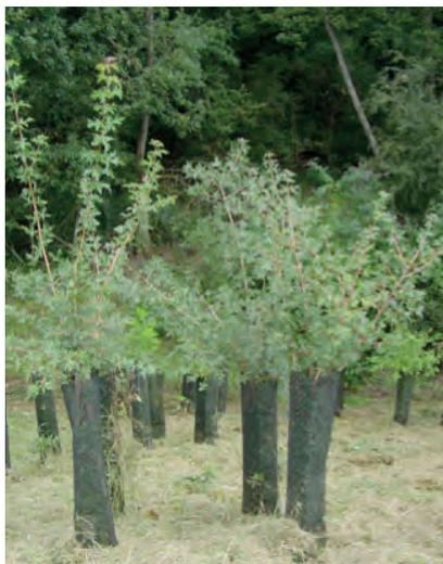
Cantiere di restauro del manto vegetale della sede dello Stabilimento AZF a Tolosa Impianto su terreno completamente inerte dopo trattamento a caldo del terreno per la bonifica.
