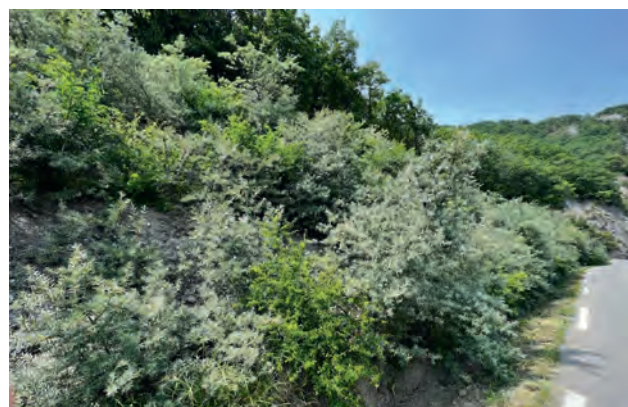
Résultats chantier de revégétalisation. Talus amont après élargissement de la route. La Rochette 05.
